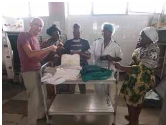
Abb. 7: Der Sterilisationsprozess des Sterilisators war fehlgeschlagen. Die Ursache war ein fehlerhafter Kondensatableiter für die Luft- und Kondensatentfernung aus der Kammer (04.12.2019).
